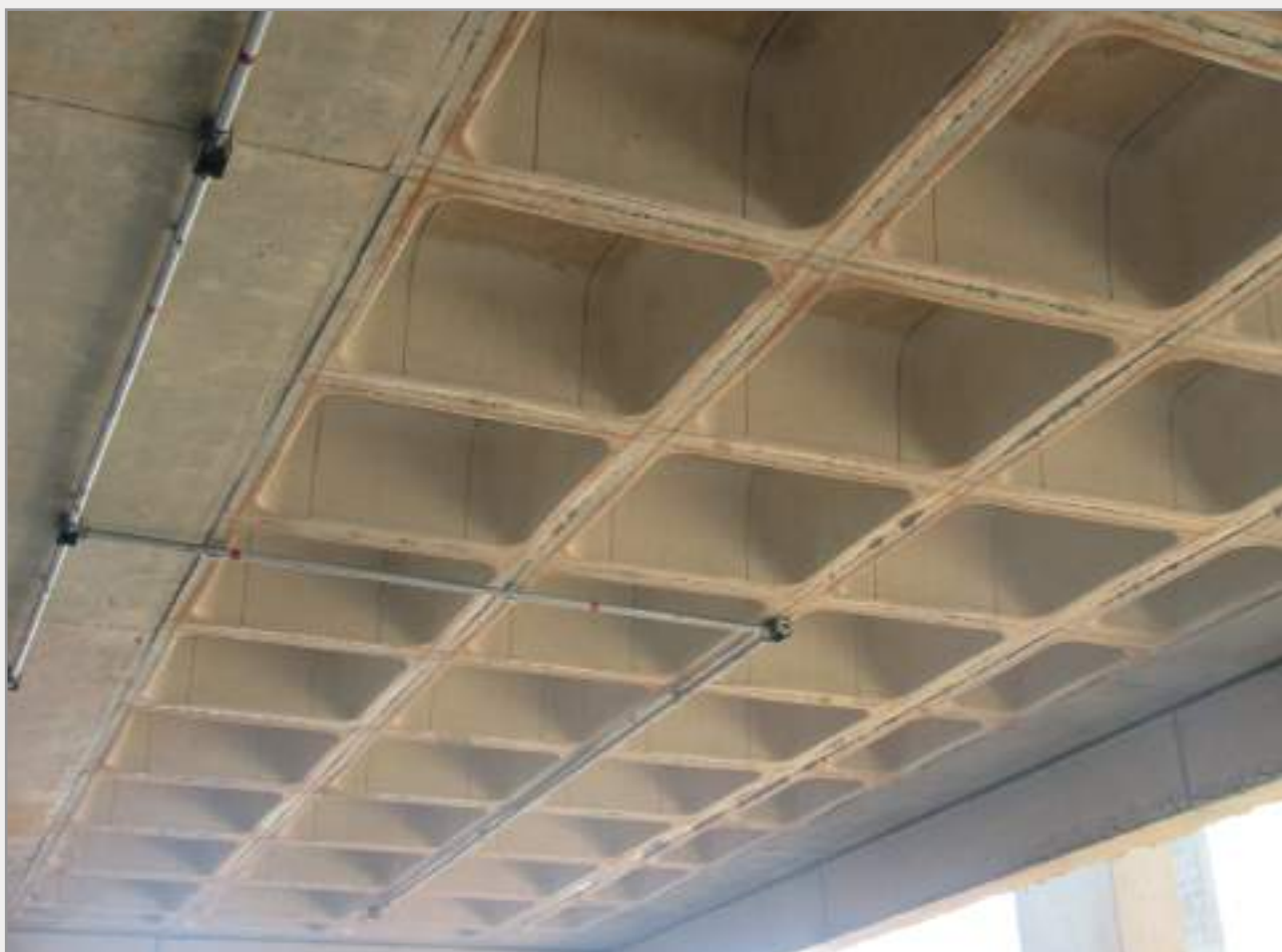
Smontaggio del solaio LAJFLEX BMATEK.
