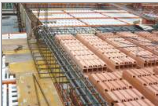
Armo Solaio Laterocemento (A)
