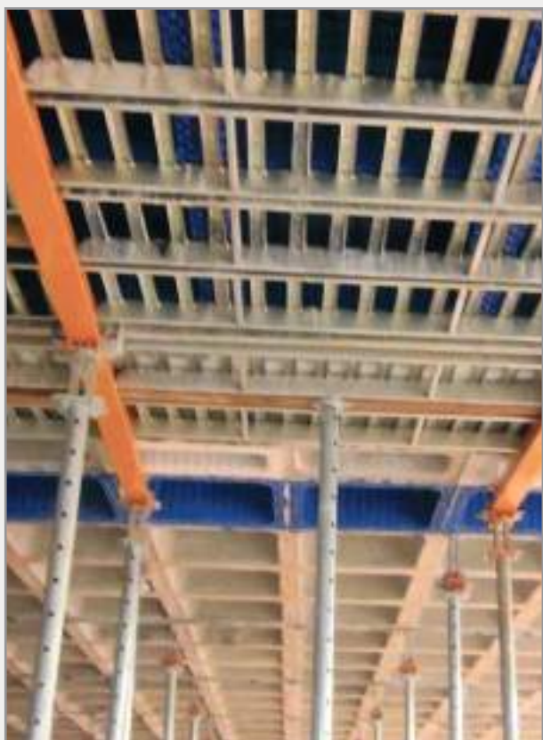
Smontaggio del solaio LAJFLEX BMATEK.
