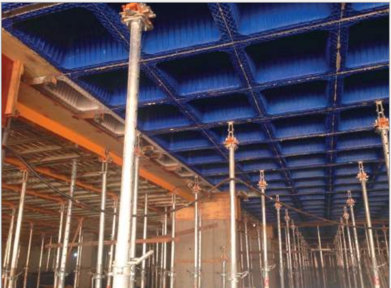
Termine del posizionamento di cubetas, compensi e travi ribassate del solaio LAJFLEX BMATEK.
