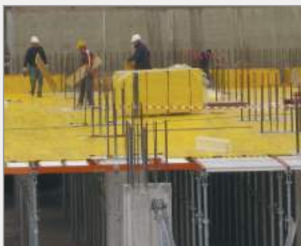
Realizzazione piano di getto
