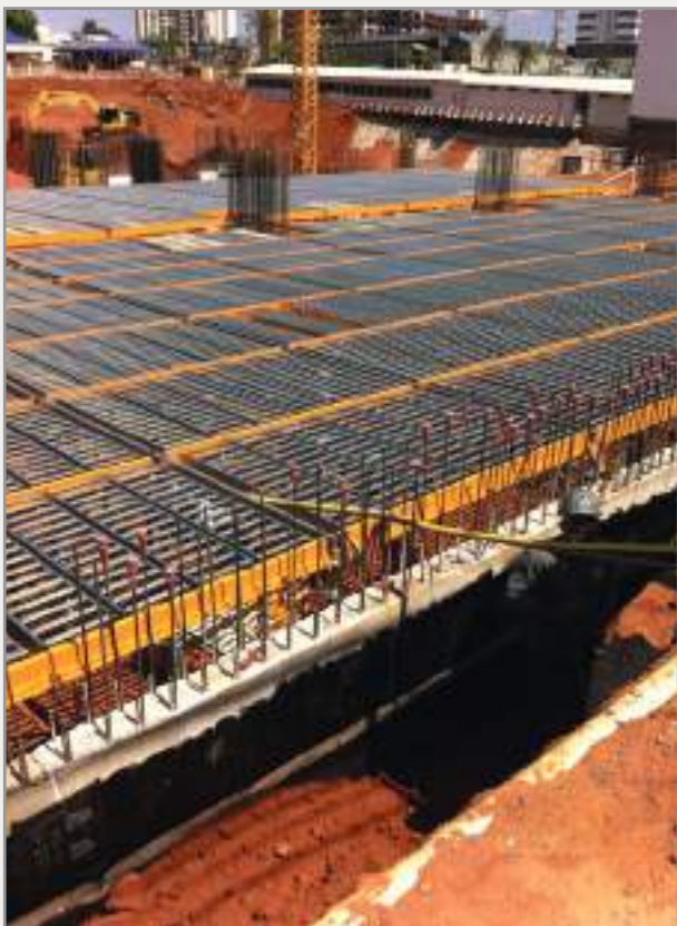
Montaggio del solaio LAJFLEX BMATEK
