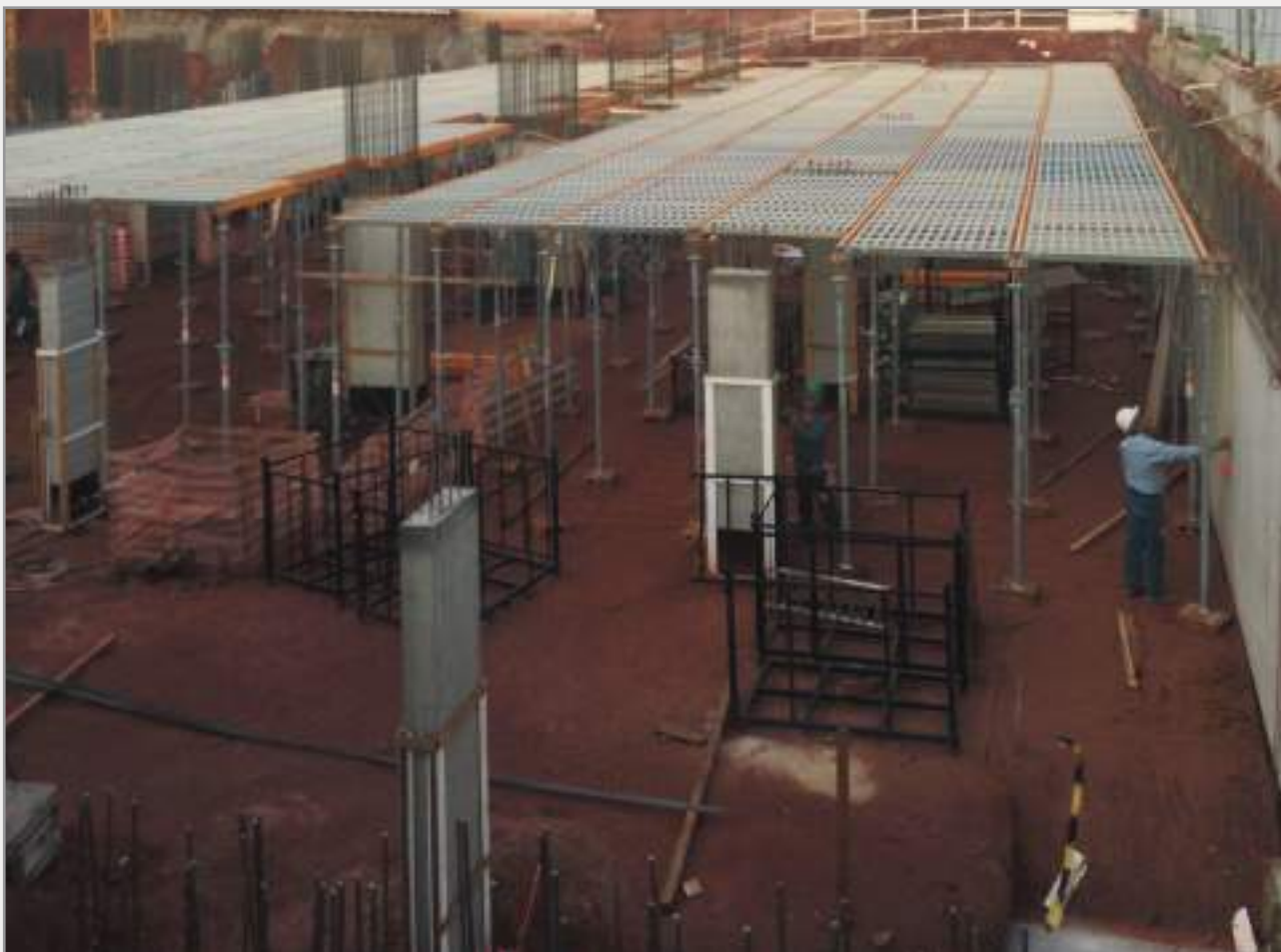
Montaggio del solaio LAJFLEX BMATEK
