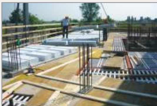
Armo Solaio Prefabbricato (B)
